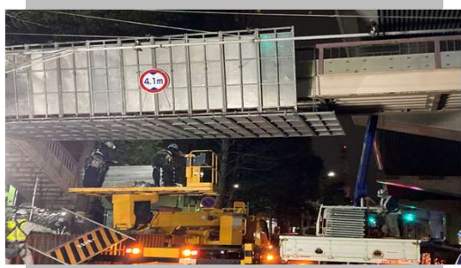
橋りょう塗装
